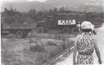
自衛隊が災害派遣として 堤防の修繕工事に出勤
