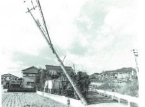
傾いた電柱（南花屋敷 1 丁目 1 月 17 日）
