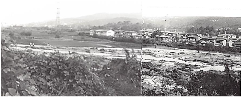
昭和 42 年 7 月豪雨では最明寺川堤防が決壊し南花屋敷 4 丁目を中心に大きな家屋被害があった。川底掘削工事や堤防補強工事が行われ、以降最明寺川は溢れていない。
